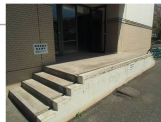
▲搬入出口 W1.8m x H2m (階段あり・地面からの高さ約750mm)
