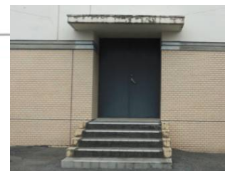
▲搬入出口 W1.3m x H2m (階段あり・地面からの高さ約750mm)
